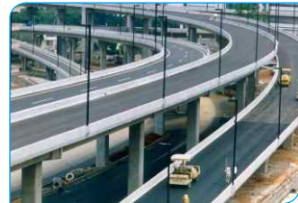
*广州广园东路高架桥
