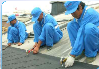
*葫芦岛奥运宏园施工现场
