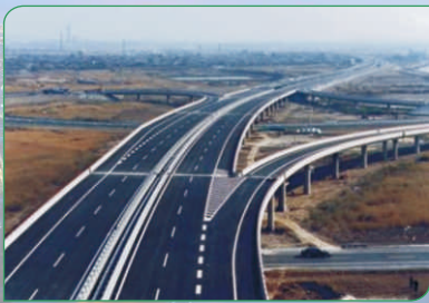
*津晋高速公路立交桥
