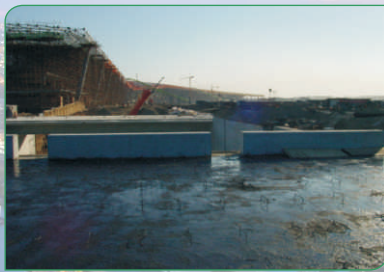
*首都机场桥面
