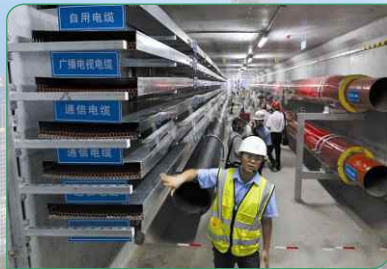
*十堰地下综合管廊
