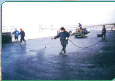
*大庆让胡路中央大街立交桥
