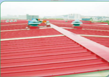
*锦西炼化总厂体育馆
